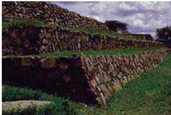
Imagen 40.- Se aprecian los muros de contención del centro ceremonial que tiene el propósito de nivelar el terreno.
