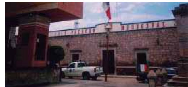
Imagen 09.- Presidencia municipal de Huandacareo, se observa la utilización de cantera en muros.
