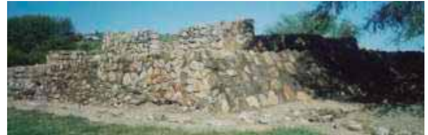
Imagen 41.- Se observa la utilización de muros inclinados, además de que las plataformas también contaban con una inclinación.
