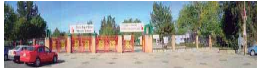
Imagen 19.- Acceso de la Unidad Deportiva "Morelos Indeco."
