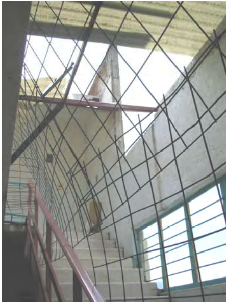
Imagen 83. Aspecto de las escaleras que conducen a la azotea. No se tiene una cubierta que impida el paso de la lluvia o el viento hacia el interior, lo que genera daños a la estructura del inmueble y una vista desagradable de las instalaciones. (Foto de la autora).
