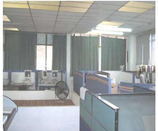
Imagen 65. Departamento de Actualización Básica. Se puede observar el deterioro en el falso plafón y el tipo de ventilación que se ocupa para refrescar el ambiente. (Foto: INEGI Michoacán.)
