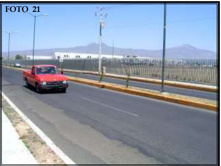
FOTO 21. Villa Universidad sin duda es la calle principal con la que colinda el terreno. Se aprecia la obra que esta en construcción de C.U.
