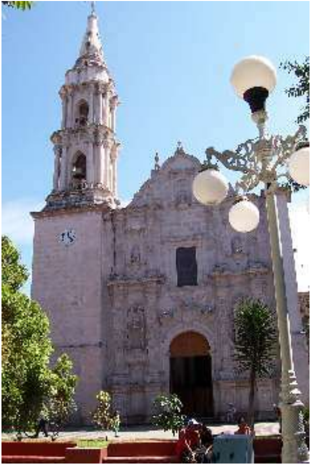
Parroquia de Los Santos Reyes Estado Actual
