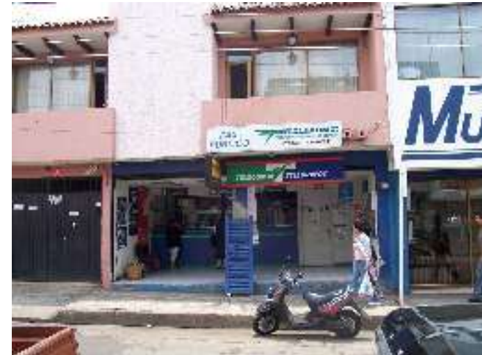
Oficina de telégrafos
