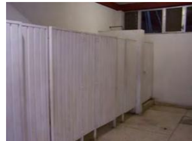
27.28.29 Sanitarios/fotografía Ulises Gerardo.
