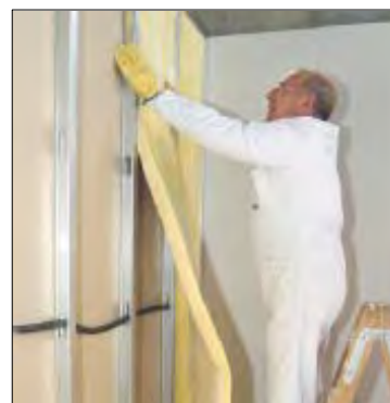
Colocación de la lana de vidrio
