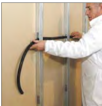
Instalación tubería luz.
