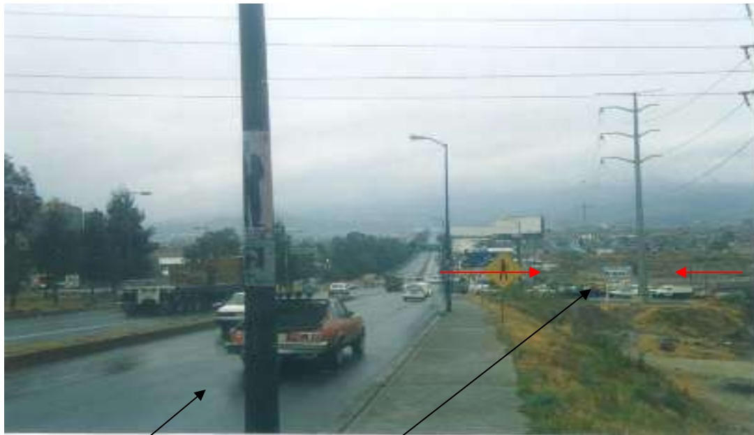
PERIFÉRICO NORTE ENTRADA Y SALIDA HACIA LA AV. TORREON NUEVO
