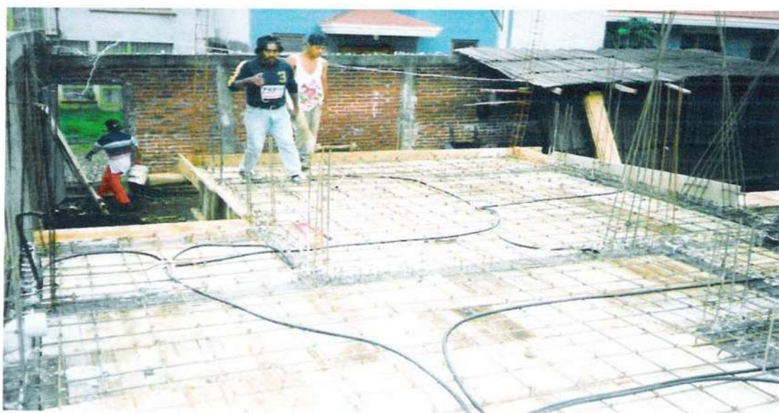
El armado de la losa de entrepiso con acero de refuerzo de 3/8" y la colocación del poliducto para la instalación eléctrica.
