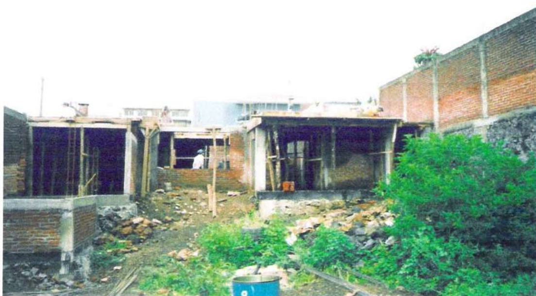
La colocación de la cimbra de madera a base de puntales y tarimas de .50 m x 1.00 m. para recibir la losa de entrepiso.
