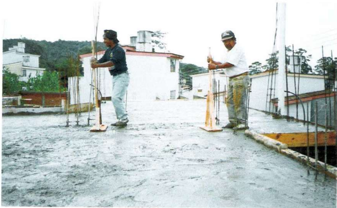
El apisonado de la losa de entrepiso una vez que se terminó de vaciar el concreto.
