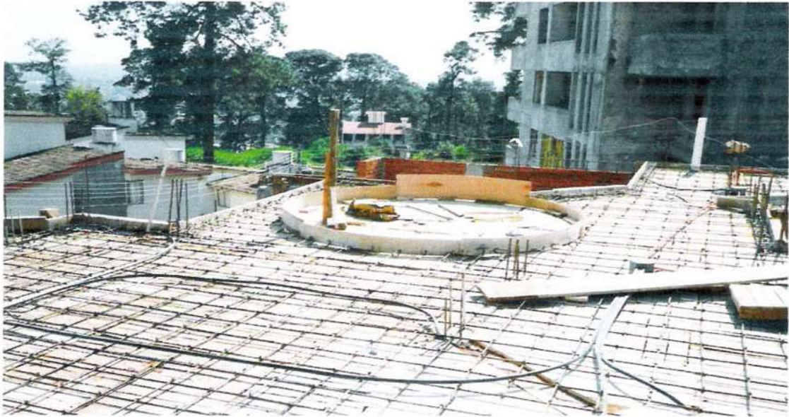
Preparación del área donde se elaborará una cúpula artesanal a base de tabique rojo recocido.
