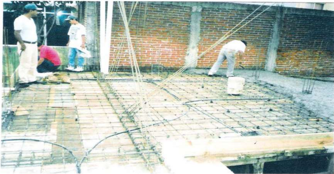
Vaciado del concreto f'c = 200 \text{ kg/cm}^2 para la losa de entrepiso con un espesor de 10 cm.
