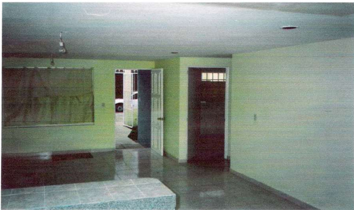
En las fotografías se muestra el terminado final de la casa y la fachada posterior de la misma.
