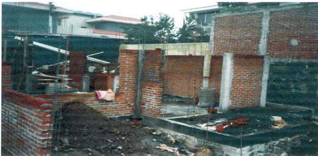
El desplante y los primeros muros de tabique de la planta baja.
