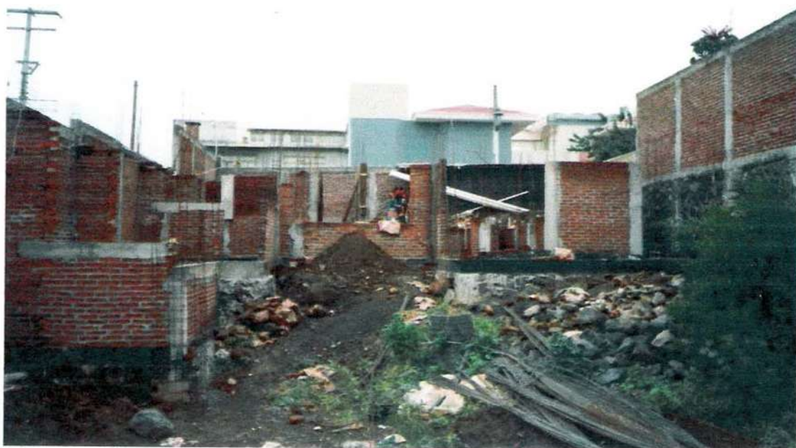
La terminación de los muros y castillos de la planta baja.
