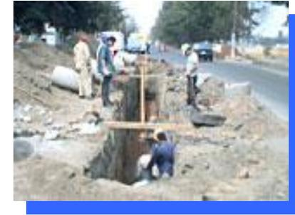
Excavacion para la ubicación del colector general, receptor del drenaje.
