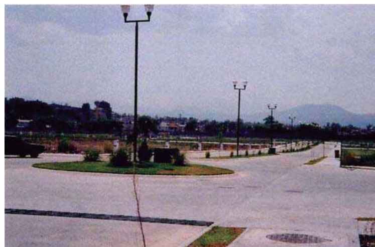
La tecnología y los materiales permiten buena ordenación de espacios y mejor equipamiento de servicios para los fraccionamientos.
