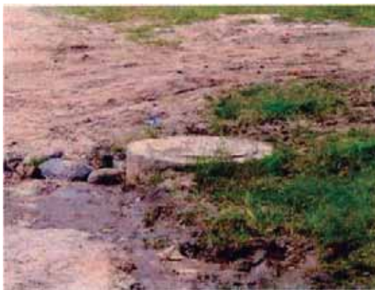
Foto 13. Algunos servicios a escasos metros del terreno.
