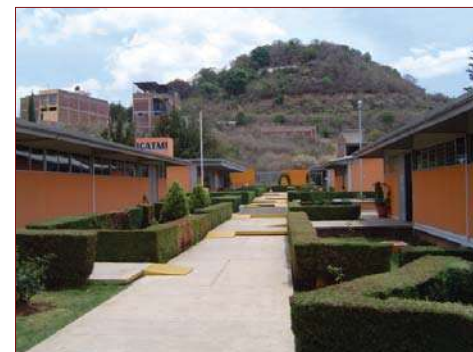
P.56 fotografía donde se aprecia el pasillo de acceso a talleres.
