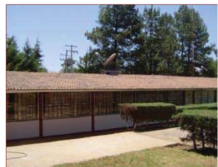
P.61 fotografía, áreas de talleres y acometida de servicios.
