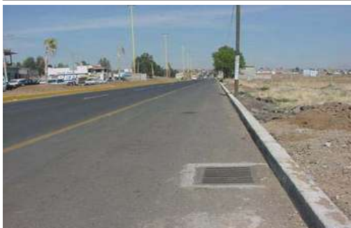
IMAGEN : 1.8 drenaje pluvial
