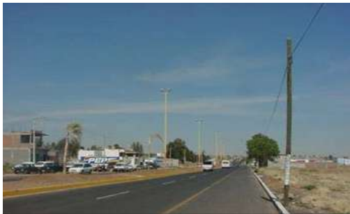
IMAGEN : 1.9 línea de teléfono
