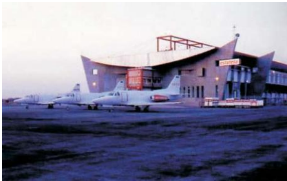
Area de descarga mensajería aérea.
