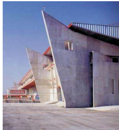
Patio de maniobras.
