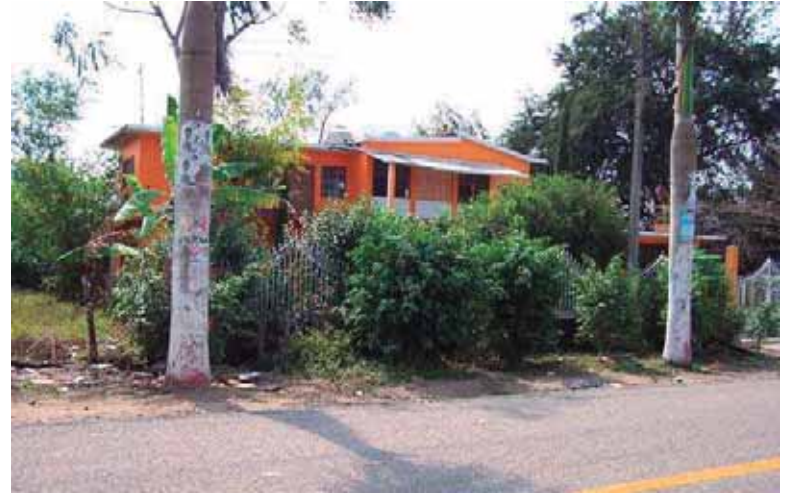
Vivienda construida con concreto y prefabricados. (2)
