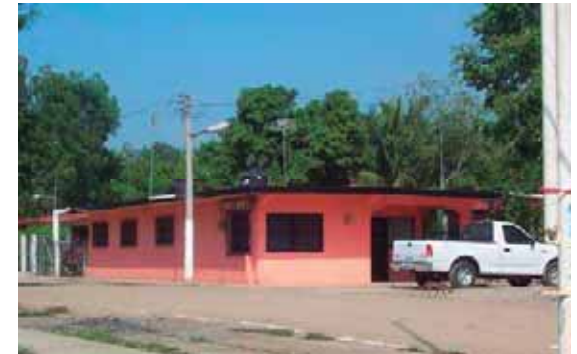
Vivienda construida con concreto y prefabricados. (2)
