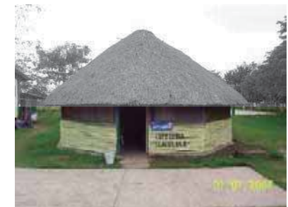
Vista exterior de cafetería (2)
