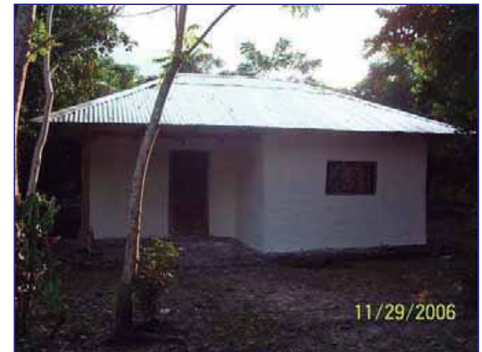
Vivienda terminada con muros de lodo y cubierta de lámina. (2)
