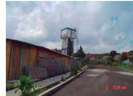
Vista contexto urbano ( Escuela Secundaria) y vialidad
