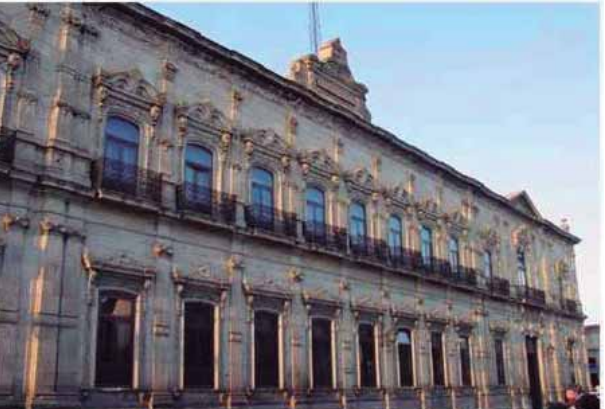
FIG. 7 Edificio de Correos de Morelia.
