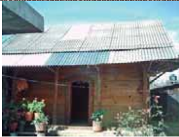
Figura 71.- Disminución del Peralte
