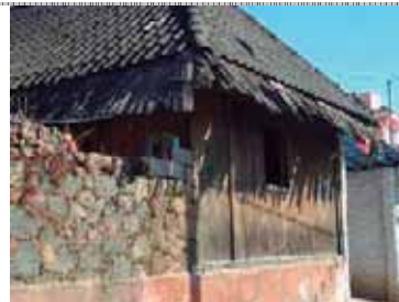
Figura 73.- Cambio de Material en Cubierta.
