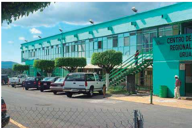
Imagen 37. Acceso y estacionamiento al Cereso.
