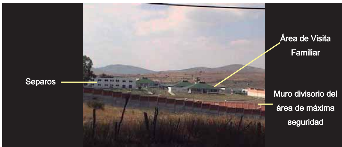
Imagen 32. En esta imagen se puede apreciar el área de visita familiar denominadas como palapas y el área de separos
