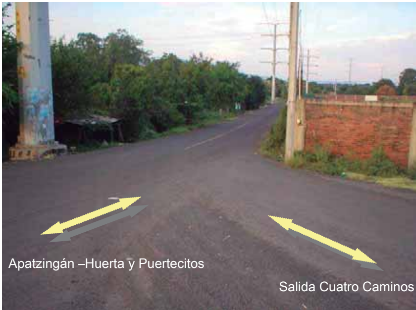
Imagen 22. Foto 16 acceso a la localidad de Hacienda la huerta – Puertecitos. Carretera Apatzingán-Uruapan vía de acceso al CERESO.
