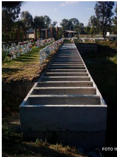
FOTO 15.- MENDOZA (2005) Sistema constructivo en Panteón Municipal de Moroleón, Guanajuato.
