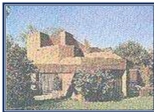
Fachada de la Casa Díaz Barreiro
