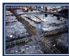
Armado de varilla para cadena y castillo
