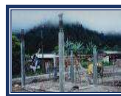
Columna de concreto armado
