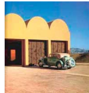
Fachada de la Casa Petaluma
