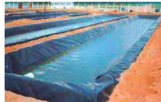
Tanque construido en suelo arenoso, revestido con film de polietileno para eliminar las pérdidas de agua por filtración.
