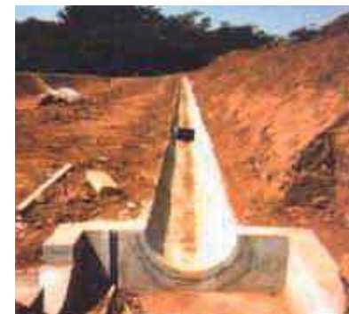
Canal de abastecimiento construido con canaletas de cemento del tipo media caña.
