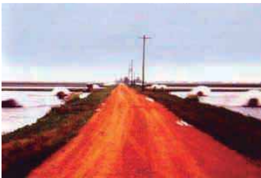
Estanque de 4 ha, borde libre con gramilla e inclinación del talud, tope de coronamiento ancho y suficiente para el tráfico de camiones.
