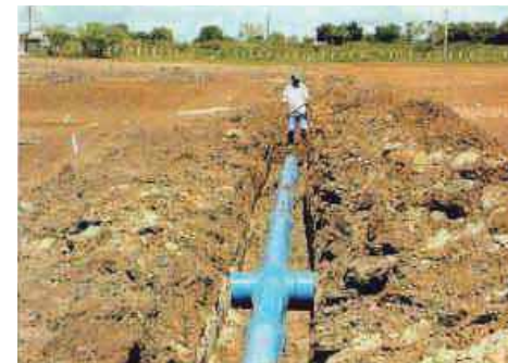
Instalación de tuberías de abastecimiento sobre el dique principal. De la cruceta derivan los tubos a cada estanque.
