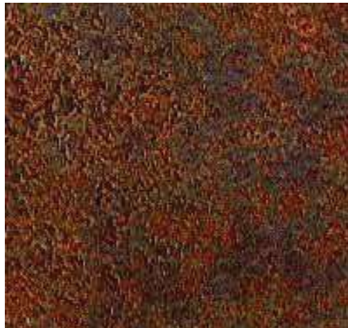
Estado original del metal (25)
