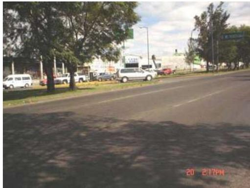
Fig. 4.8. Imagen de la superficie del pavimento, donde se observa que las líneas que dividen los carriles prácticamente no se notan.
