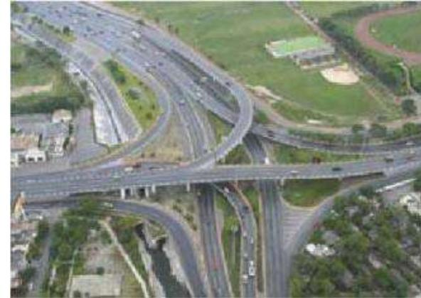
Fig. 2.21. Ejemplo de intersección de trompeta.
