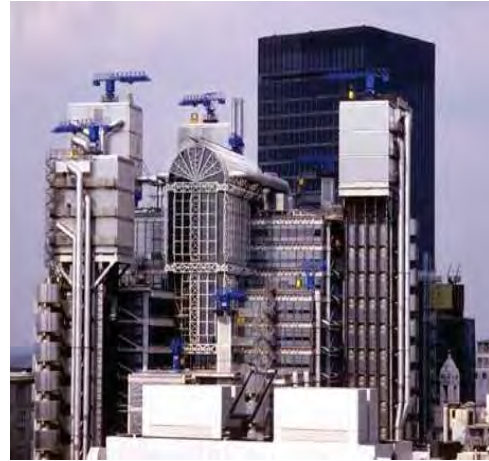
Edificio del Lloyds Bank en Londres 27. El edificio del Lloyds Bank, proyectado por Richard Rogers, se concluyó en 1986. Una de sus principales características es el empleo de elementos estructurales vistos, fabricados en acero inoxidable.
