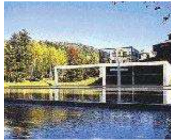
Capilla sobre el agua Tomamu
