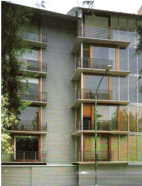
IMAGEN 19/EDIFICIO PLATON EXTERIOR /FUENTE: AUTOR TESIS
