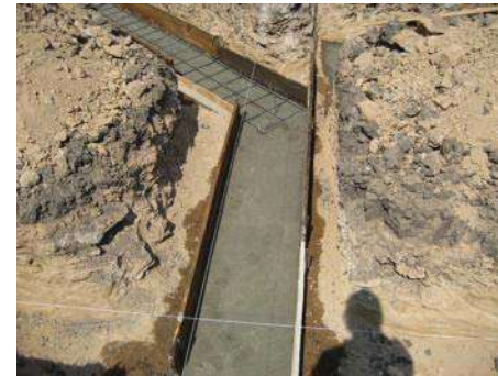
IMAGEN 81/ ZAPATA. CORRIDA. /FUENTE: AUTOR TESIS
