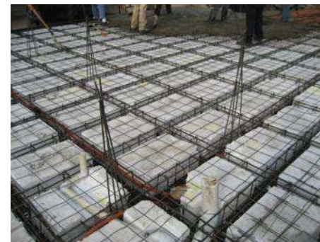
IMAGEN 83/ARMADO DE LOSA RETICULAR /FUENTE: AUTOR TESIS
