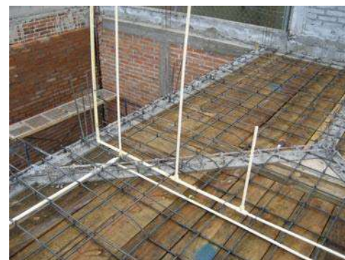
IMAGEN 91/ HIDRAULICA CON /CPVC P.A /FUENTE: AUTOR TESIS
