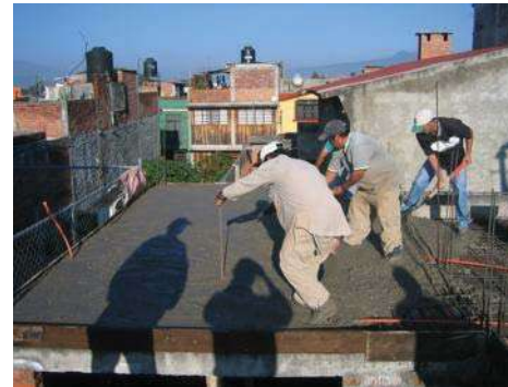
IMAGEN 87/COLADO LOSA MACIZA /FUENTE: AUTOR TESIS
