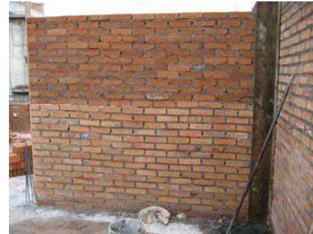
IMAGEN 84/MURO TABIQUE /FUENTE: AUTOR TESIS
