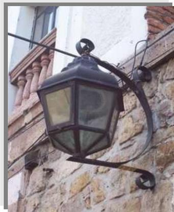
Foto N o.19 La mayoría de las luminarias requieren de mantenimiento ya sea de aplicar otra capa de pintura y limpieza y/ o restitución de cristales.
