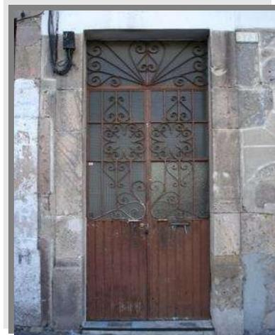
Foto N o.17, 18. La presencia de oxido, graffiti y la pintura deteriorada hacen que se aminore la herrería de las puertas.
