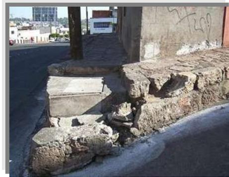
Foto N .28 L as fracturas que presenta la banqueta impide que la gente pueda transitar sobre la misma.
