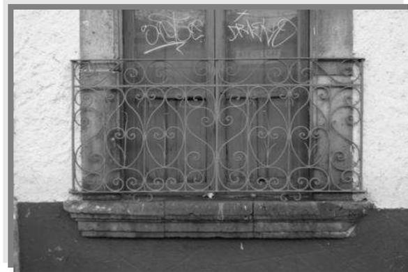
Foto N o.16 No solo las piezas de cantería se encuentran dañadas también algunos elementos de herrería que presentan la pintura deteriorada
