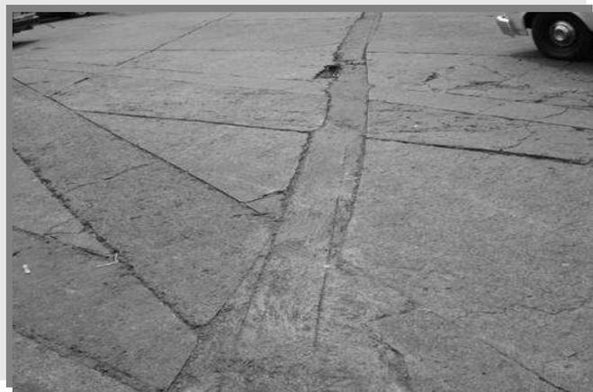
Foto No.26 Gran parte del pavimento vehicular, presenta grietas, deformaciones o aberturas, al igual una continua circulación vehicular
