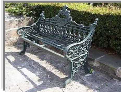
Foto N o. 31 A simple vista se puede ver las piezas faltantes al igual el deterioro de la pintura
