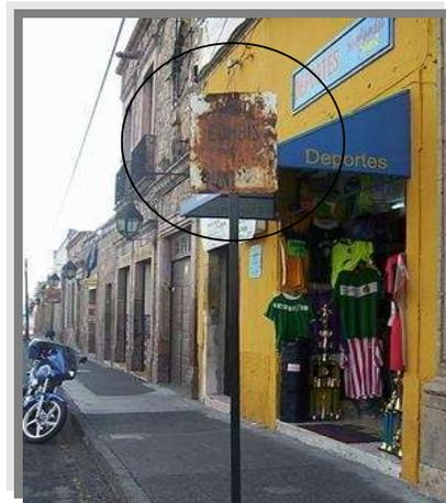
Foto N o. 25 La presencia de óxido en este señalamiento impide la visualización clara sobre su contenido.
