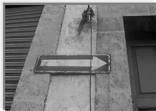
Foto N o.24 Señalamiento de sentido de la calle fijada sobre el muro de cantería dañando el inmueble como así mismo presentando óxido por la falta de mantenimiento.
