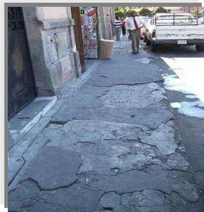
Foto N o. 27 E xfoliación de las capas de concreto.
