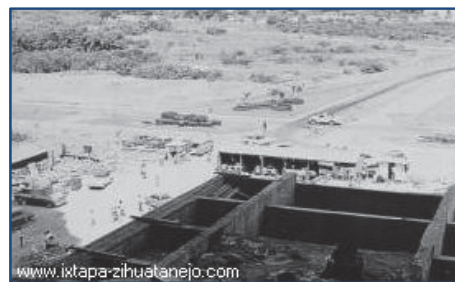
Construcción del primero hotel en Ixtapa en 1971, “Hotel Aristos”
