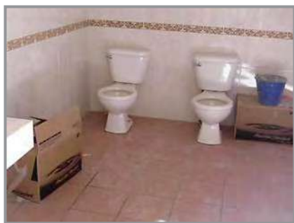
Se observa como se esta adaptando el edificio tratando de cubrir las carencias con las que cuenta actualmente.
