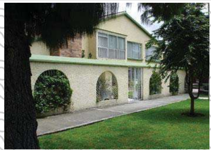
Fig. V.1 Fachada Hostal Bogotá Real, Colombia.
