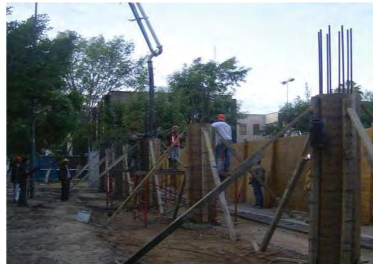
Imagen 6.63 Concreto premezclado en columnas
