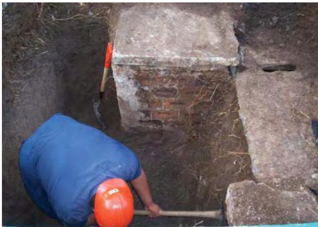
**Imagen 6.36** Excavación por medio manual
