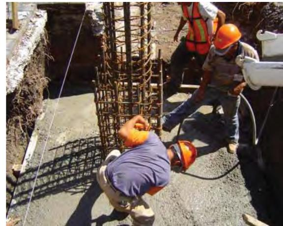
Imagen 6.50 Concreto Premezclado en cimentación
