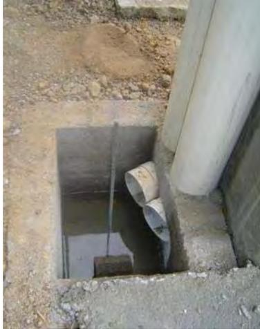
**Imagen 6.86** Tubo de PVC para desagüe
