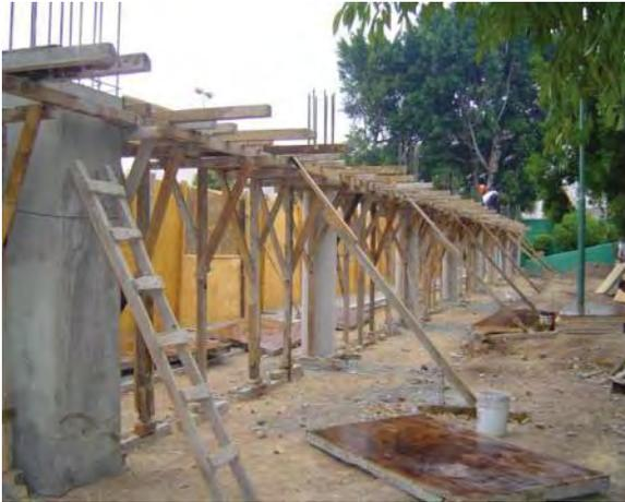
**Imagen 6.66** Colocación de Cimbra de madera en trabes
