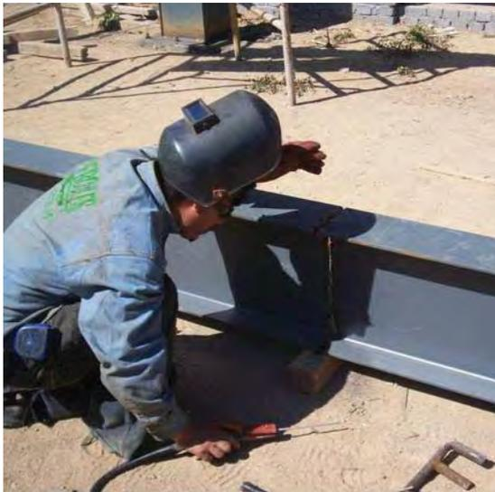
Imagen 6.73 Soldadura de estructura metálica
