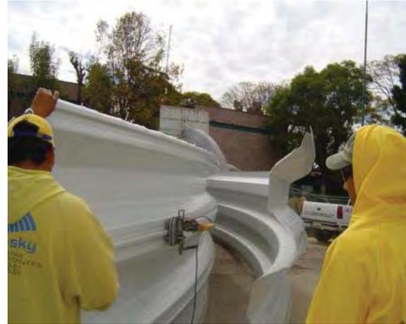
Imagen 6.101,6.102, 6.103 y 6.104 Habilitado y montaje de lámina pintro para arcotecho
