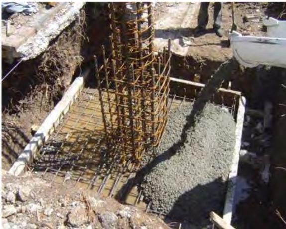
Imagen 6.49 Concreto premezclado en cimentación
