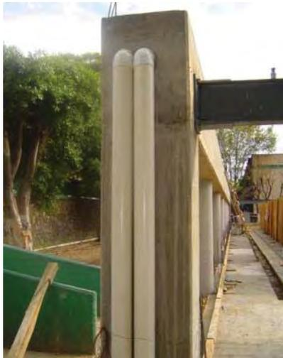
**Imagen 6.87** Tubo de PVC para desagüe
