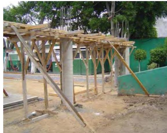
**Imagen 6.68** Colocación de cimbra aparente de contacto en trabes
