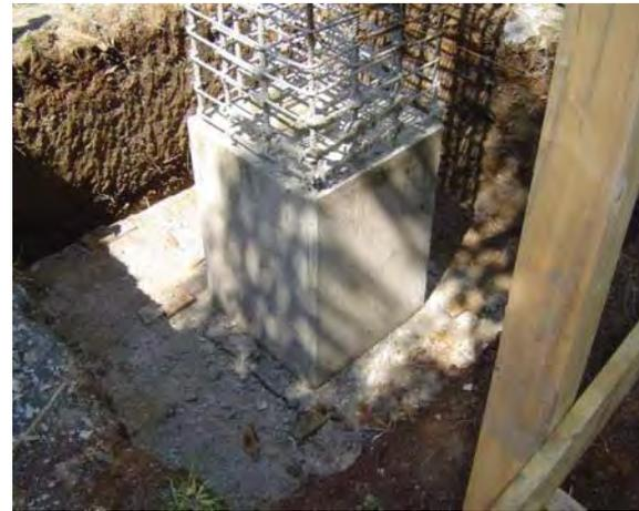
Imagen 6.55 Zapata y dado de concreto
