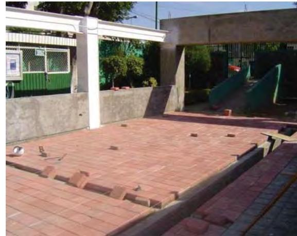
**Imagen 6.96** Colocación de piso de adocreto en el perímetro de la alberca
