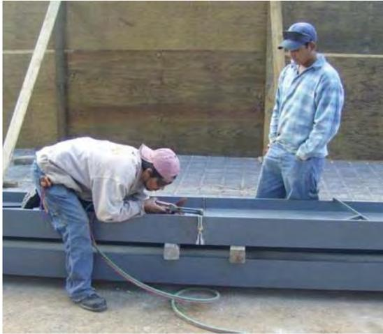
Imagen 6.72 Soldadura de estructura metálica
