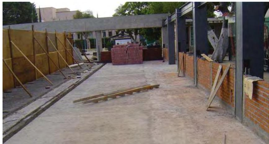
**Imagen 6.90** Muro de tabique rojo en barda perimetral
