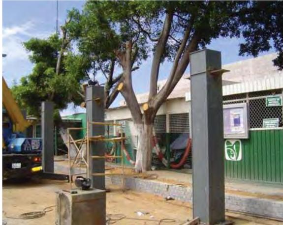
**Imagen 6.77** Preparación para Colocar viguetas de acero estructural
