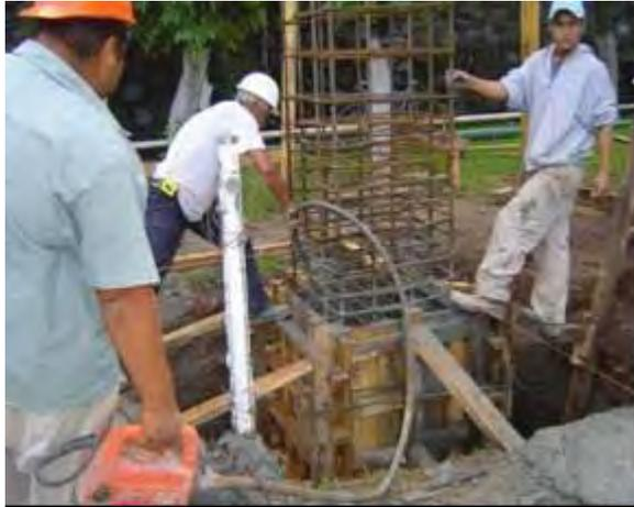
Imagen 6.53 concreto premezclado en dados
