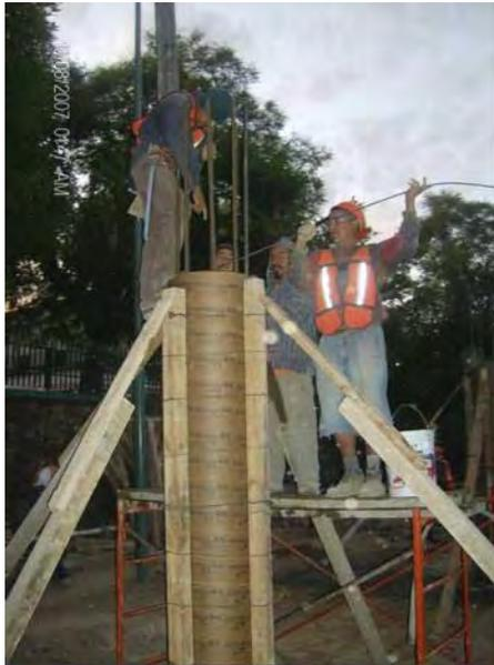
Imagen 6.61 Concreto premezclado en columnas
