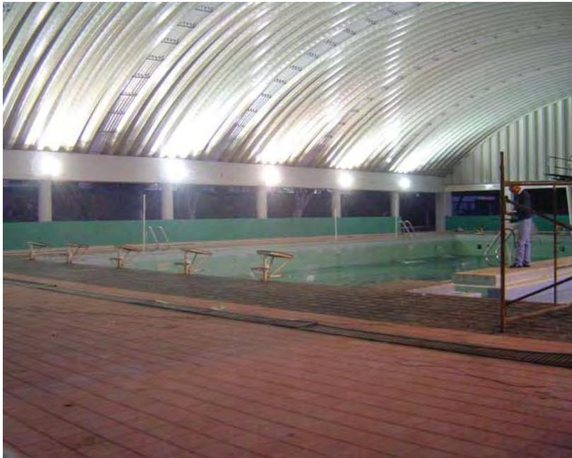
Imagen 6.109 Cubierta de Arcotecho
