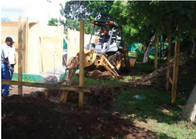
**Imagen 6.37.** Excavación por medio mecánico
