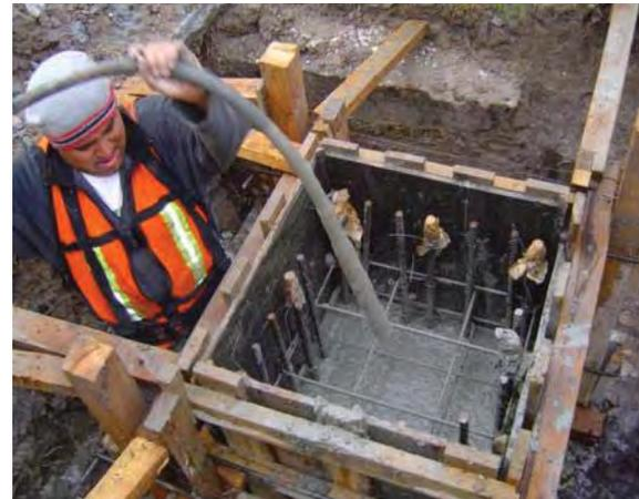
**Imagen 6.60** Colado de Concreto premezclado en dados
