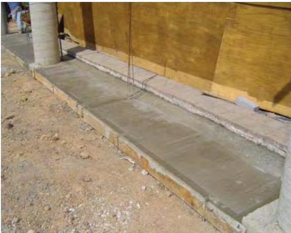
**Imagen 6.65** Firme de concreto de 10 cm., acabado escobillado
