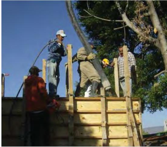
**Imagen 6.83** Colocación de Concreto premezclado en trabe y recolector
