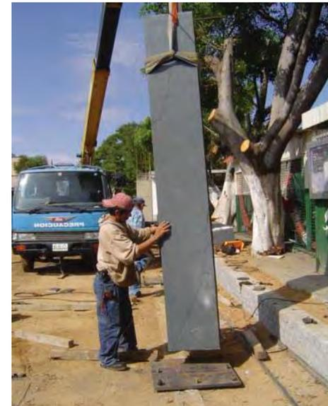
Imagen 6.76 Montaje de columnas metálicas
