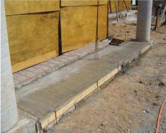
**Imagen 6.64** firme de concreto de 10 cm., acabado escobillado
