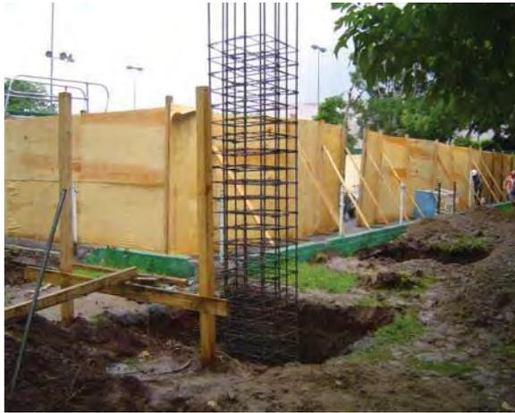
**Imagen 6.46** Acero de Refuerzo en columnas
