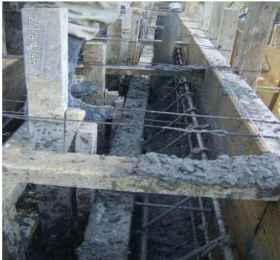
**Imagen 6.84** Concreto premezclado en trabe y recolector
