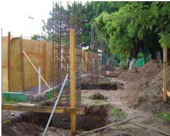
**Imagen 6.47** Acero de refuerzo en columna
