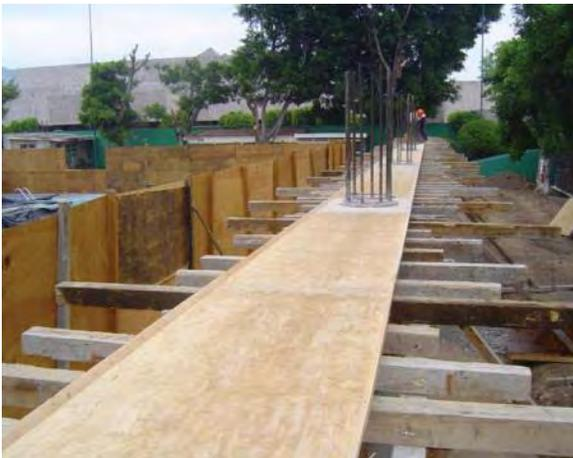
**Imagen 6.67** Colocación de cimbra aparente de contacto en trabes
