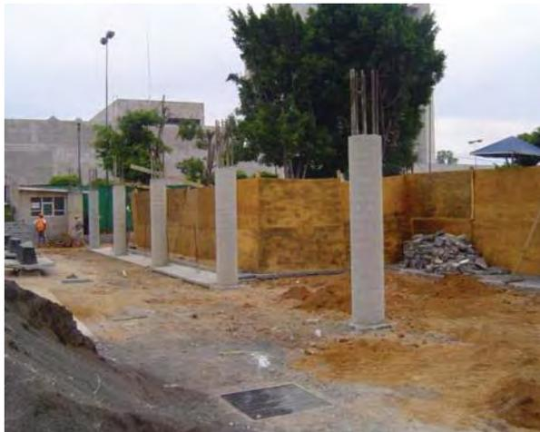
Imagen 6.62 Concreto premezclado en columnas
