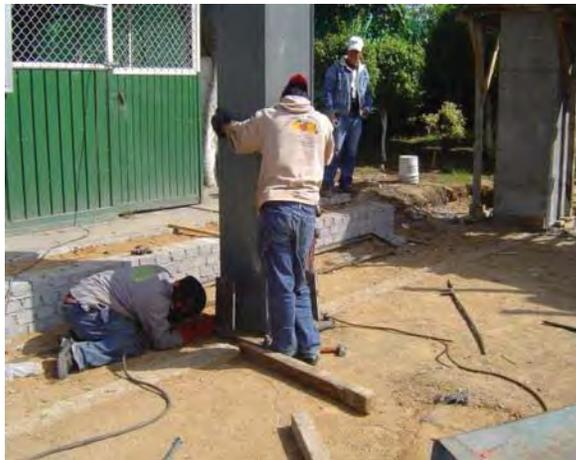
Imagen 6.75 anclaje de columnas metálicas
