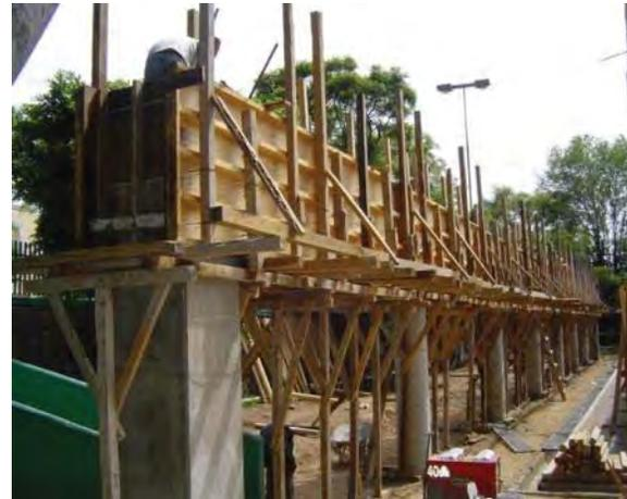
**Imagen 6.71** Cimbra y acero de refuerzo en trabe recolectora de agua pluvial
