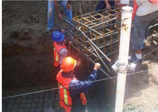
**Imagen 6.44** Colocación de armado en cepas
