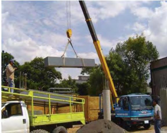
Imagen 6.74 Colocación de columnas metálicas
