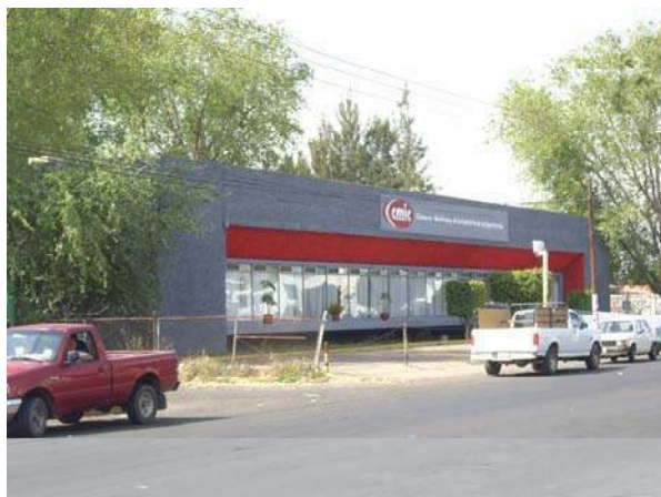
IMAGEN 23. Camara Mexicana de la Industria de la Construcción
