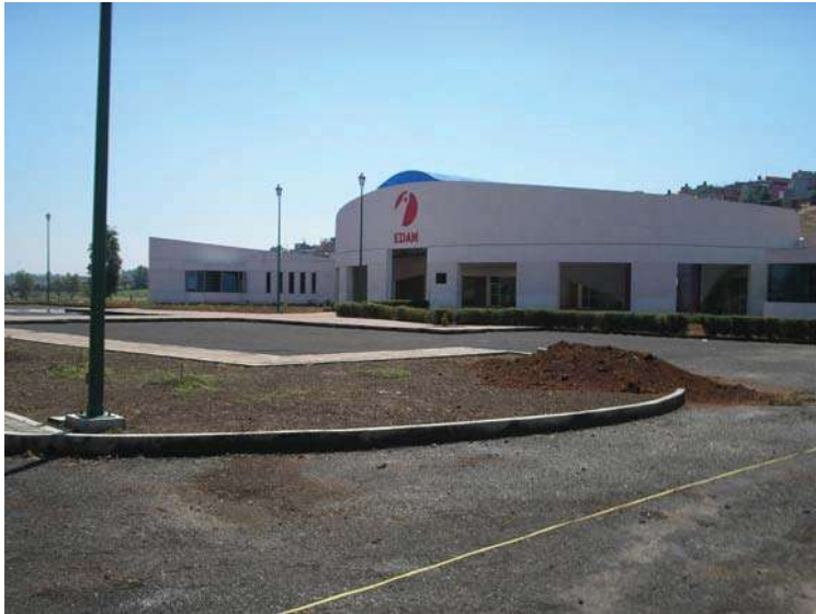
Acceso vehicular y peatonal al EDAM. Trabajos de jardinería finiquitados al igual de pintura en exteriores
