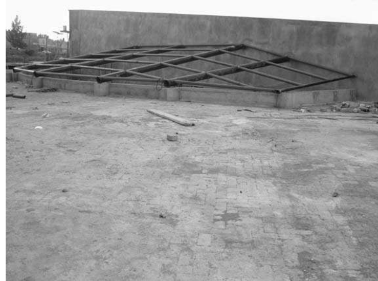
Enladrillado en azotea y estructura metálica
