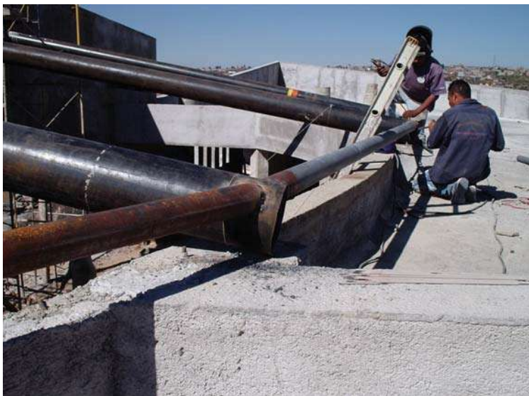
Estructura metálica en losa de azotea, aun sin terminado final.
