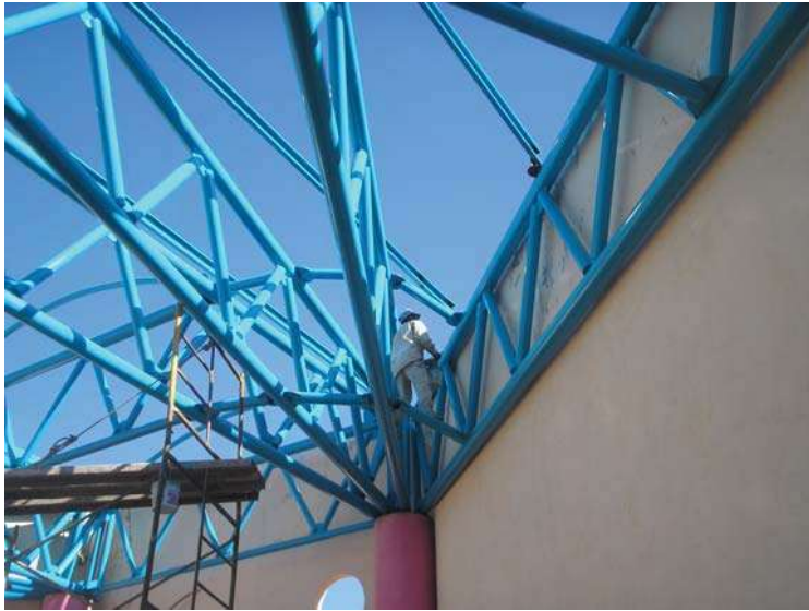
Terminado de estructura metálica en puntos de apoyo.
