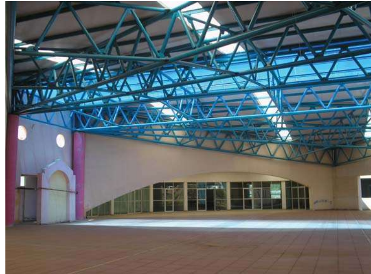
Terminado de estructura metálica con cubierta de multipanel e iluminación con lamina acrílica y policarbonato azul
