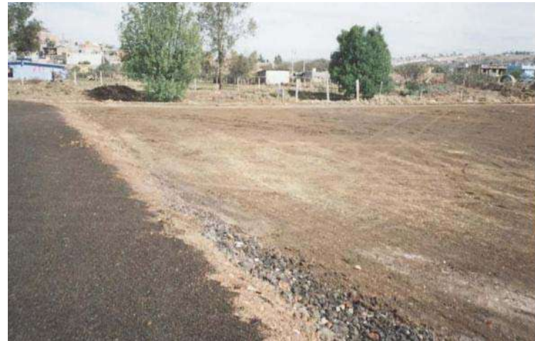
Terreno con materia de mejoramiento compactado.
