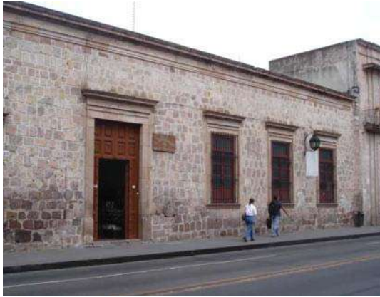
FACHADA PRINCIPAL "ASILO DE ANCIANAS DIVINO REDENTOR"
