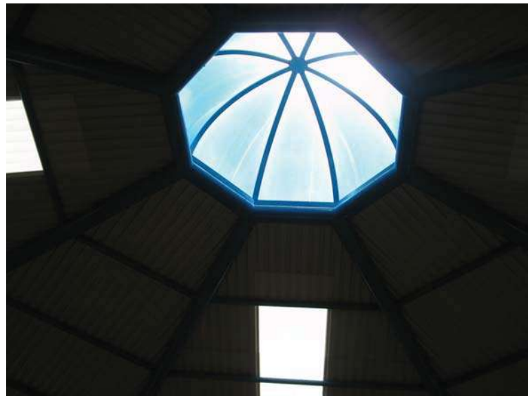
Estructura en salón de usos múltiples a base de tubo mecánico, lamina pinto, lámina acrílica y policarbonato azul.
