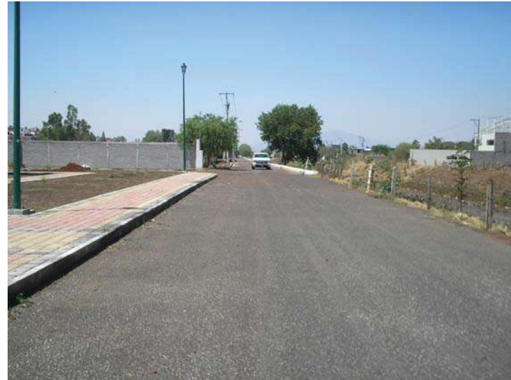
Acceso vehicular culminado.
