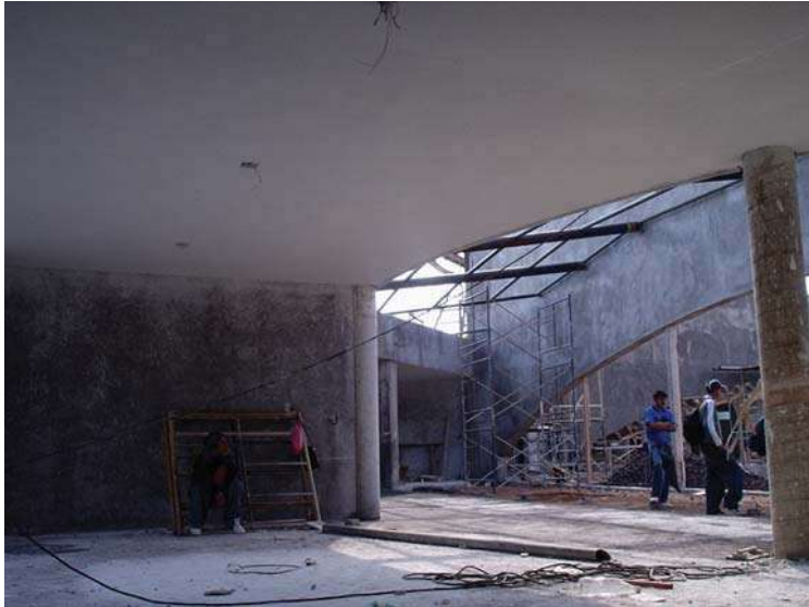
Colocación de estructuras metálicas en techo.
