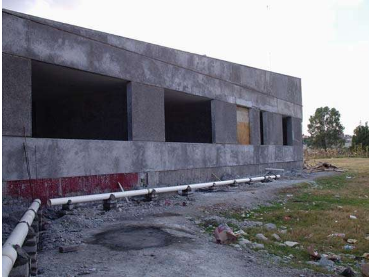
Aplanados e instalaciones sanitarias.
