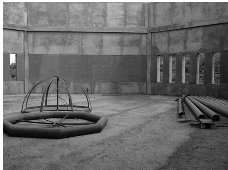
Preparación de estructura para salón de usos múltiples, Acabado con repellado tipo rustico.
