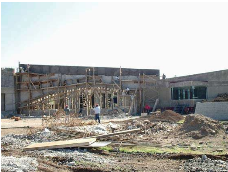
Construcción de muros y elaboración de aplanados en los mismos.
