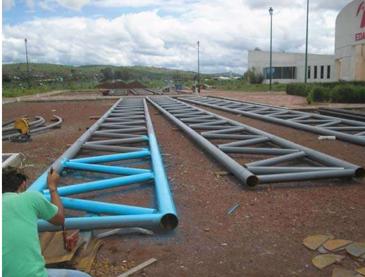
Fabricación de armadura y preparación de pintura para la misma.
