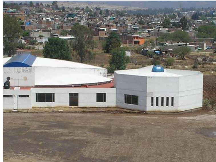
Área posterior limpiada y nivelada
