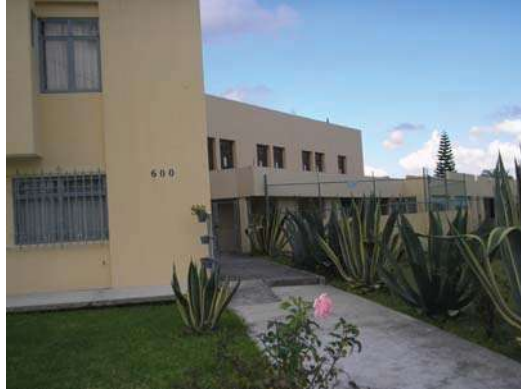
FACHADA LATERAL "RESIDENCIA DON VASCO"
