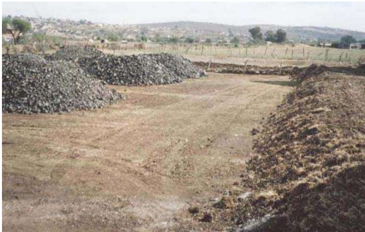
Mejoramiento de terreno con material filtro, greña y cementante en edificio y estacionamiento
