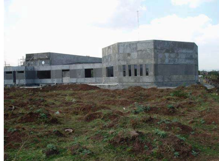
Acabado rustico en exteriores. Tierra de producto de excavación aun sin extender para nivelación de terreno.
