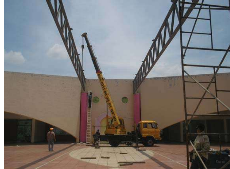
Colocación de estructura metálica con grúa en toda la zona del vestíbulo principal.
