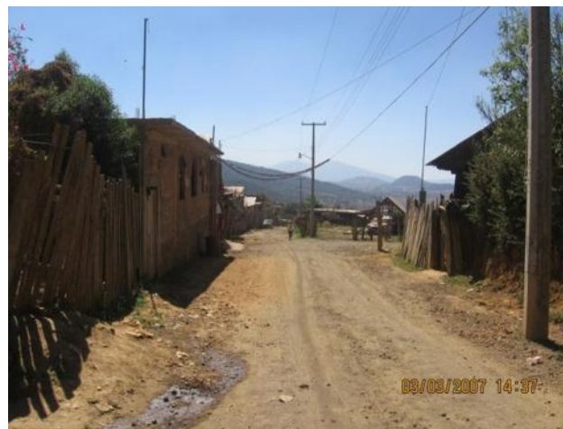
Calle sin pavimentar
