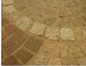
Adoquín de hormigón marca belartza de medidas 26x16x6 Modelo mediterráneo y natural. Aplicado en plazas.
