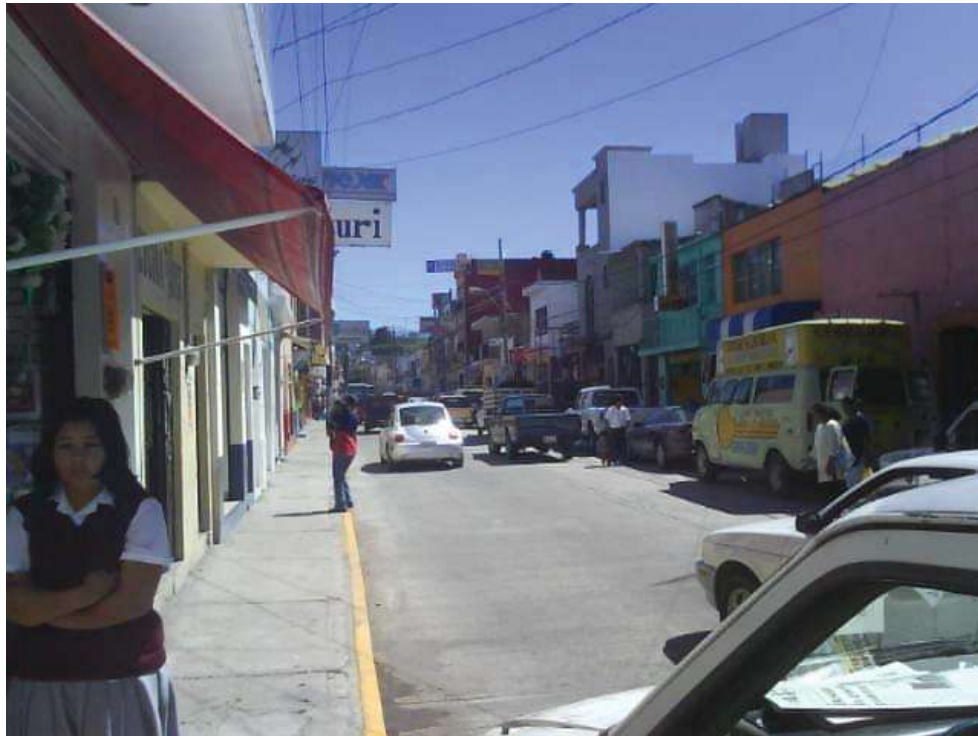
Urbanización de la zona centro del sector
