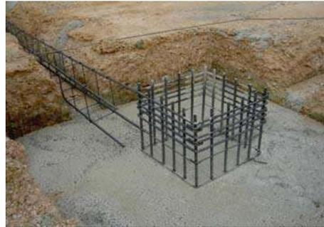
El traslado de las cargas de los muros interiores será por medio de zapatas corridas de concreto armado a lo largo de los mismos.
