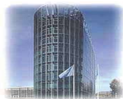
IMAGEN 41.- Fachada del edificio de la OMM
