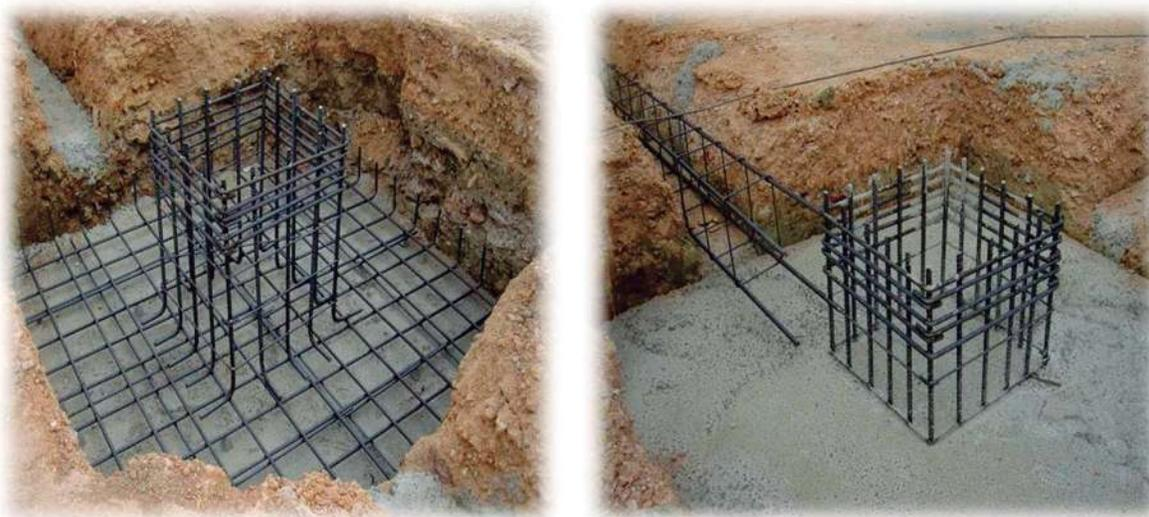
**Ilustración 10**, fotos que muestran el armado y preparado de la cimentación en zapatas aisladas.
