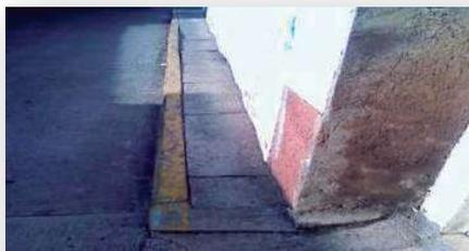
FIG 5: Banqueta con dimensiones inapropiadas. Fotografía tomada por Francisco Arroyo 24/octubre/08
