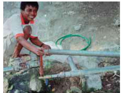
Imagen 34/imagen de tubería antigua/ fuente: de mis investigaciones y reportes fotográficos en maruata. 60
