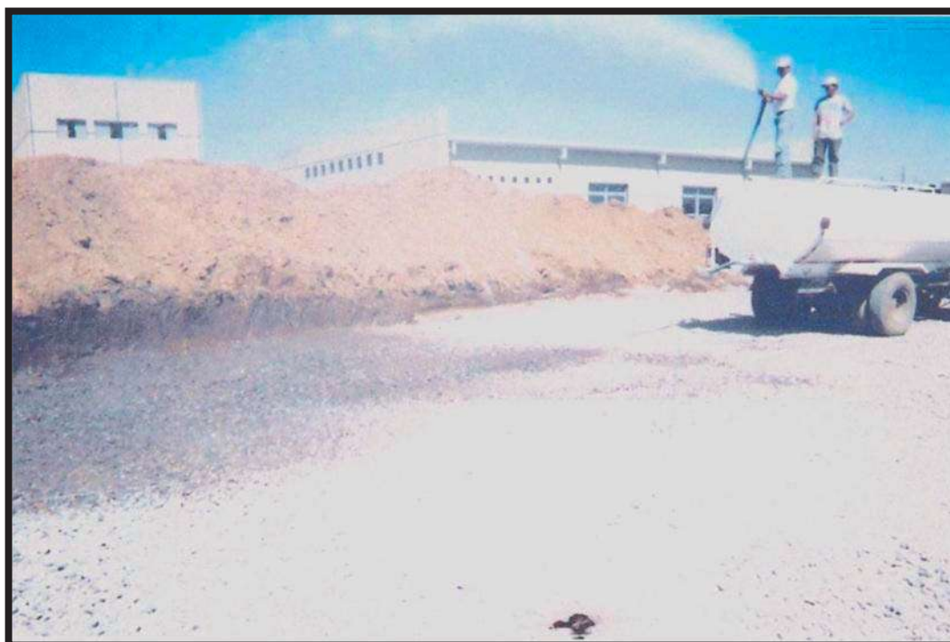
Imagen 4.- Incorporacion de agua para compactar terreno
