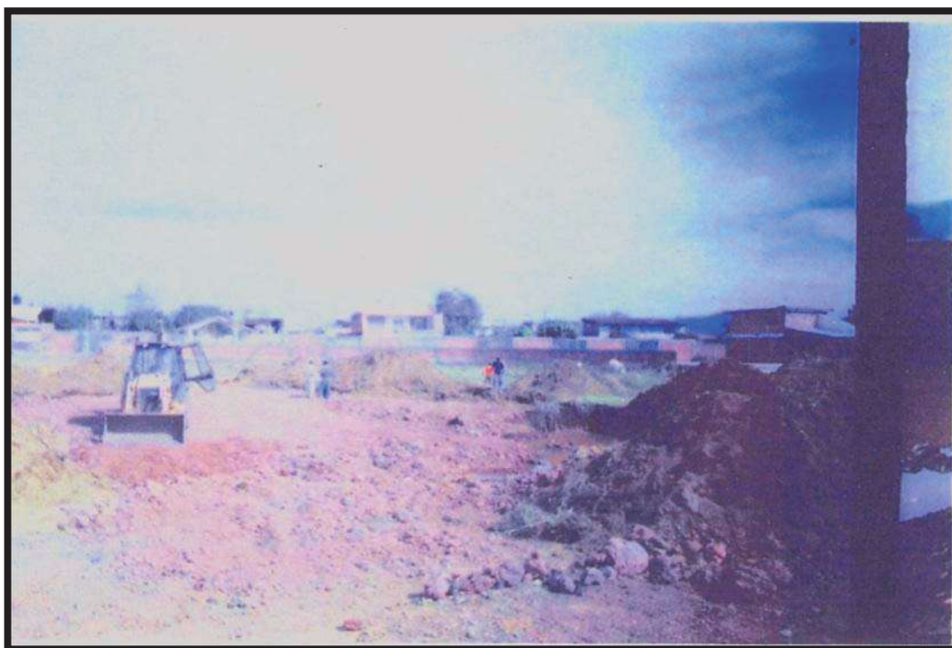
Imagen 2.- Trabajos de excavación
