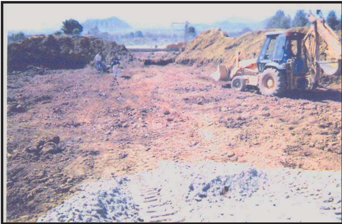
Imagen 1.- Trabajos de topografia
