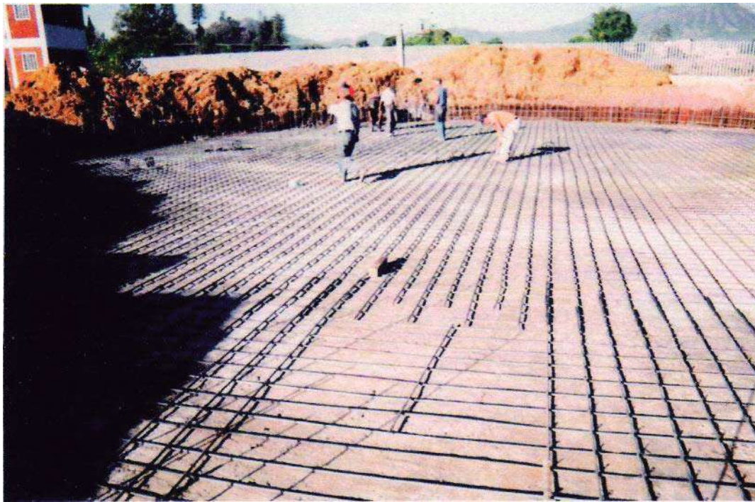
Imagen 7.- Colocación del acero de refuerzo
