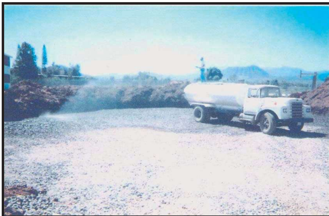
Imagen 3.- Incorporacion de agua para compactar terreno
