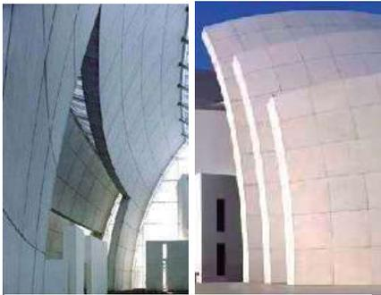
87.- Estructura metálica, con metal desplegable y cemento. con recuadros en relieve.
