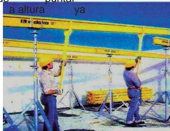
Traslape de largueros para ajustara la longitud requerida
