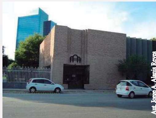
Imagen 44. Control de acceso peatonal.
