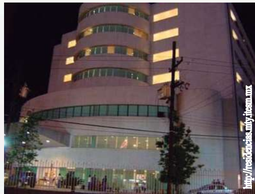
Imagen 32. Fachada principal de edificio III.
