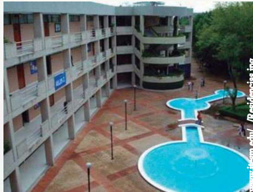
Imagen 56. Edificio de Aulas.
