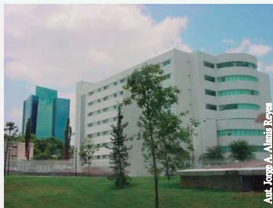
Imagen 42. Fachada poniente de Residencias III.
