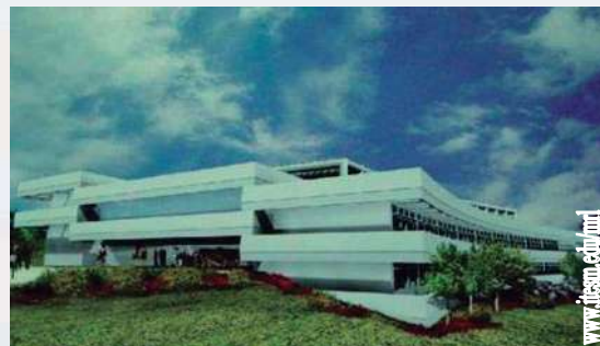
Imagen 26. Edificio de Aulas.
