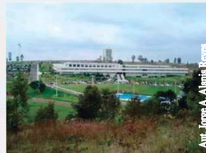
Imagen 27. Vista del edificio de Profesional.
