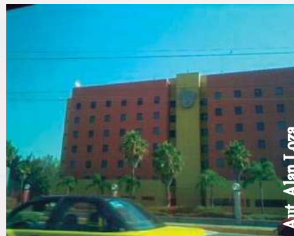
Imagen 62. Fachada posterior de Residencias.
