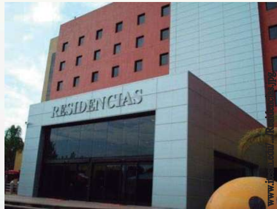
Imagen 53. Acceso principal al edificio.
