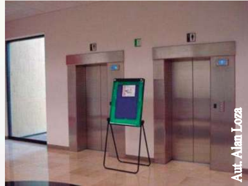
Imagen 66. Área de elevadores.
