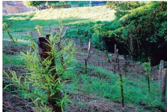
Fig.39 Estaquillado de sauce. El sistema radical contribuye a la estabilidad de un relleno de suelos. Carlos Enrique Escobar
