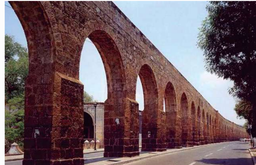
Imagen: 15. Acueducto de Morelia. http://media.photobucket.com/image/historia%20morelia/alexmatos1/Acueducto-Morelia.jpg
