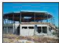
Vista de fachada lateral derecha, antes de la demolición de la pared.
