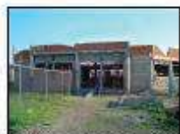
Vista de fachada lateral izquierda, antes de la demolición de la pared.
