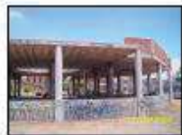
Vista de fachada posterior, mostrando la estructura de concreto.
