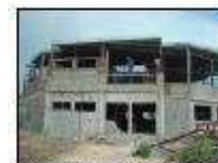
Vista lateral derecha, antes de la demolición de la pared.
