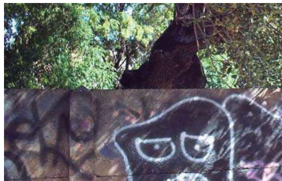
Imagen 92. Vandalismo e incendio de vegetación en el terreno elegido para desarrollar el proyecto, visita de campo. Por Meza Zamora Jesús Germán. Enero de 2008.
