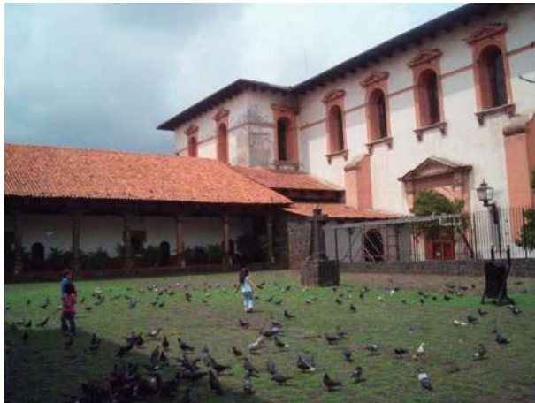
Vista del interior de la Huatapera y parte de la iglesia 78
