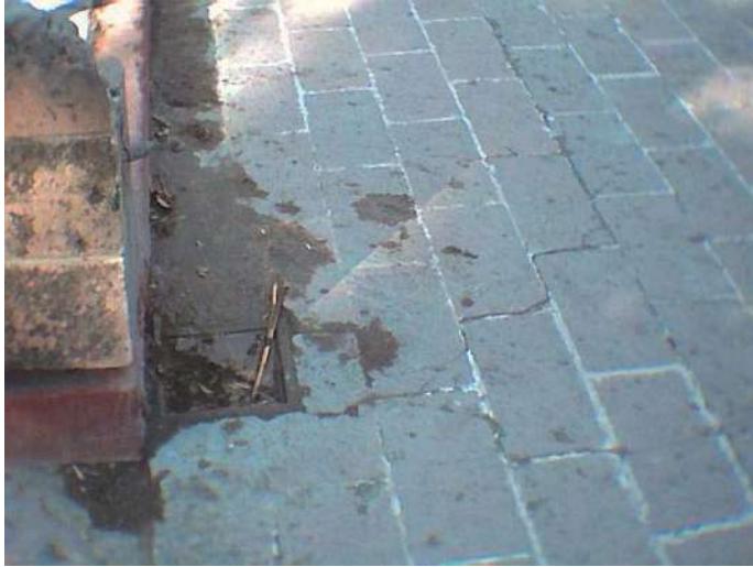
Salidas de agua para el servicio del cementerio. 67
