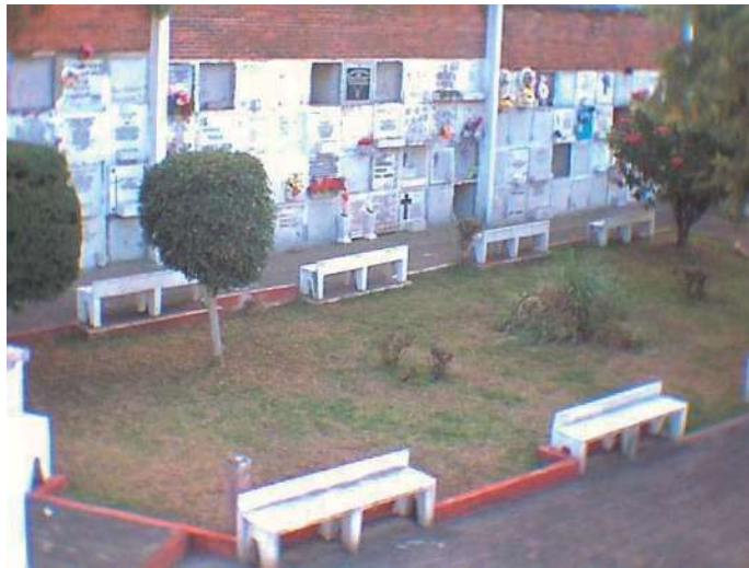
Vista del área de gavetas y osarios 64
