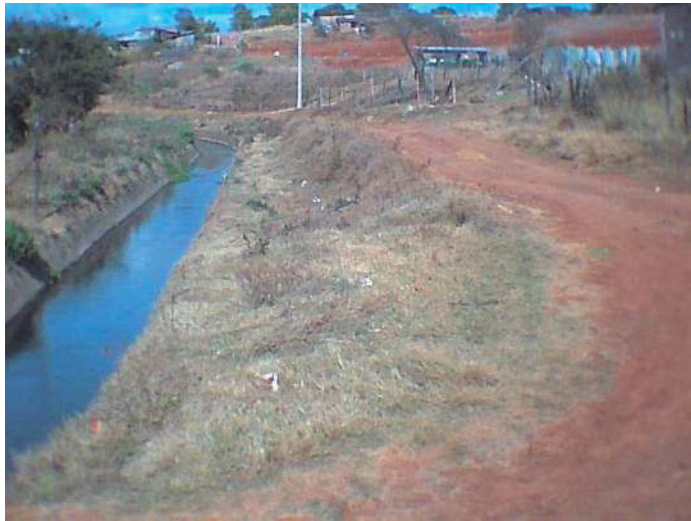
CANAL HACIA LA PLANTA TRATADORA DE AGUA 21
