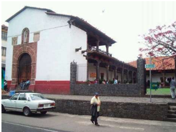
Vista del frente de la Huatapera 77
