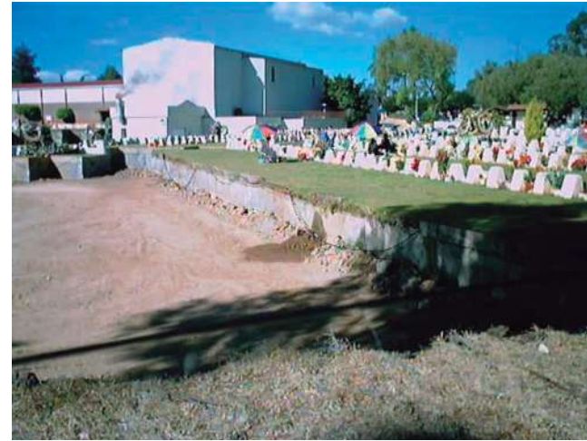
Excavación del terreno que permite ver el tipo de suelo 71
