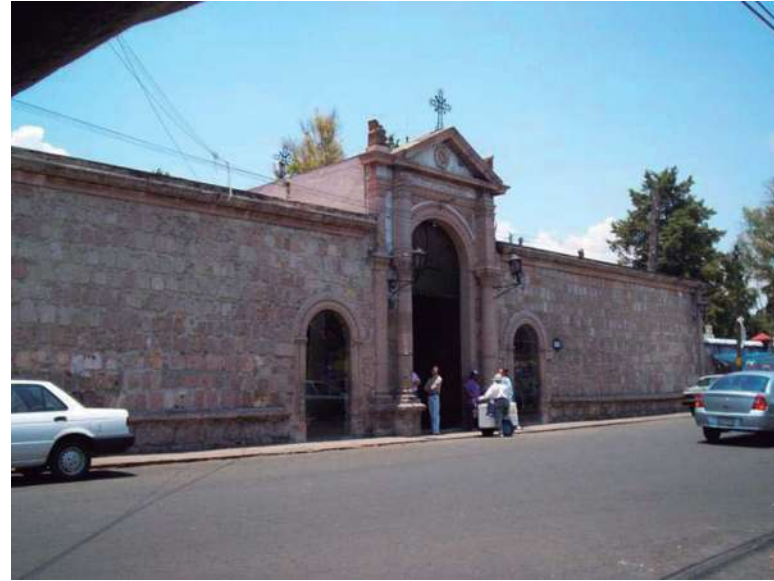
Acceso principal al cementerio y oficinas administrativas. 63
